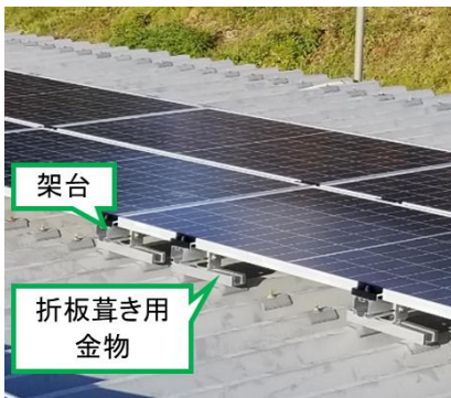
折板葺き屋根設置状況写真
